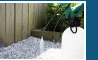
Appliquez la première couche sur la surface propre et sèche, en pulvérisant lentement et de manière contrôlée, en assurant une couverture uniforme.
