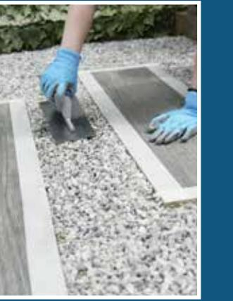
Für die zweite Schicht denselben Vorgang wie in Phase 2 anwenden. Sobald eine gleichmäßige Abdeckung erreicht ist, die Oberfläche leicht verdichten, um das beste Haftungsergebnis zu erzielen.
