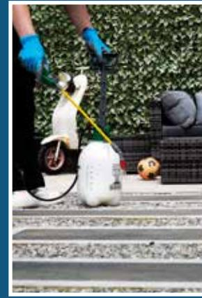
Nachdem die ersten beiden Schichten getrocknet sind, die dritte und letzte Schicht der Endbehandlung auf die Oberfläche auftragen. Trocknen lassen und falls notwendig, die Anwendung für eine bessere Haftung wiederholen.
