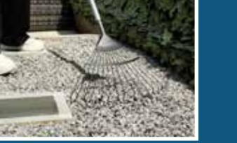
Dopo aver applicato il primo strato, rastrellare o muovere le rocce per esporre il materiale non rivestito. In questo modo ci si assicura che la superficie sia sufficientemente coperta da EASIHOLD.
