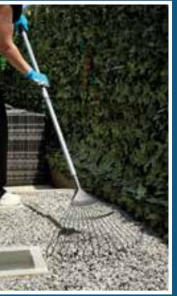
Nachdem die erste Schicht aufgetragen wurde, harken oder bewegen Sie die Steine, um das nicht beschichtete Material freizulegen. Auf diese Weise stellen Sie sicher, dass die Oberfläche ausreichend mit EASI HOLD bedeckt ist.
